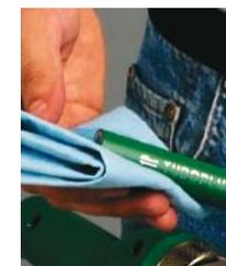
4. Limpie con un trapo húmedo en alcohol el extremo del tubo y el interior de
