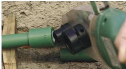
2. Caliente la hembra de la conexión el doble de tiempo. Luego caliente el tubo el tiempo normal.
