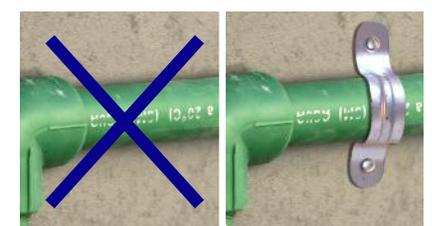
**12.** Sujetar con abrazadera fija la instalación externa, para que no se afloje.
