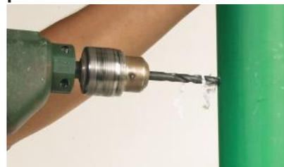
1. Descubra la tubería perforada. Coloque los dados de reparación en el termofusor. Rectifique el agujero con una broca de 8 mm.
