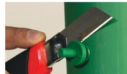
4. Introduzca sin pérdida de tiempo el tapón en el agujero de la tubería hasta la marca. Permita que se lleve a cabo el enfriamiento completo de la termofusión (ver tabla 7 de enfriamiento). Al enfriarse la termofusión cortar con cutter o navaja el excedente.
