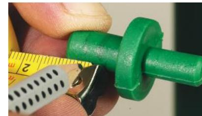
2. Marque sobre el tapón de reparación, la medida del espesor de la tubería.
