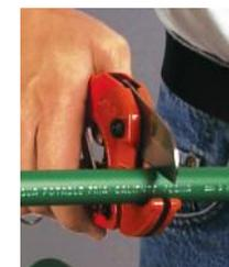
3. Mida y corte la tubería en tramos con la tijera. Para evitar rebabas no
