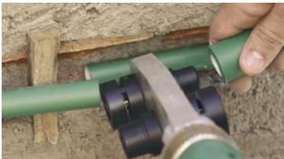
1. Descubra la zona de la tubería dañada 20 cm de cada lado de la fuga. Corte el trozo de tubería dañada. Termofusione la conexión a unir retirando el tubo de la ranura y fijándolo con cuñas de madera.
