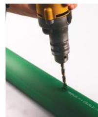
**1.** En el lugar donde se colocará la montura, perforo el tubo con una broca de 12 mm.
